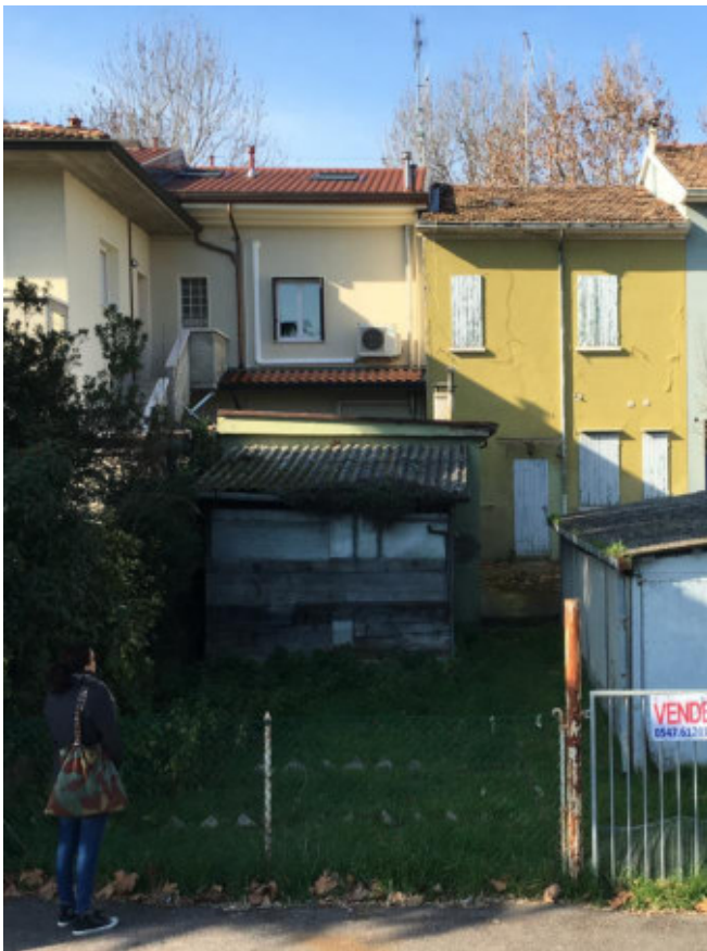
Fig.3 – Il fronte est dell'edificio preesistente, inserito nel tessuto storico di case a schiera.
