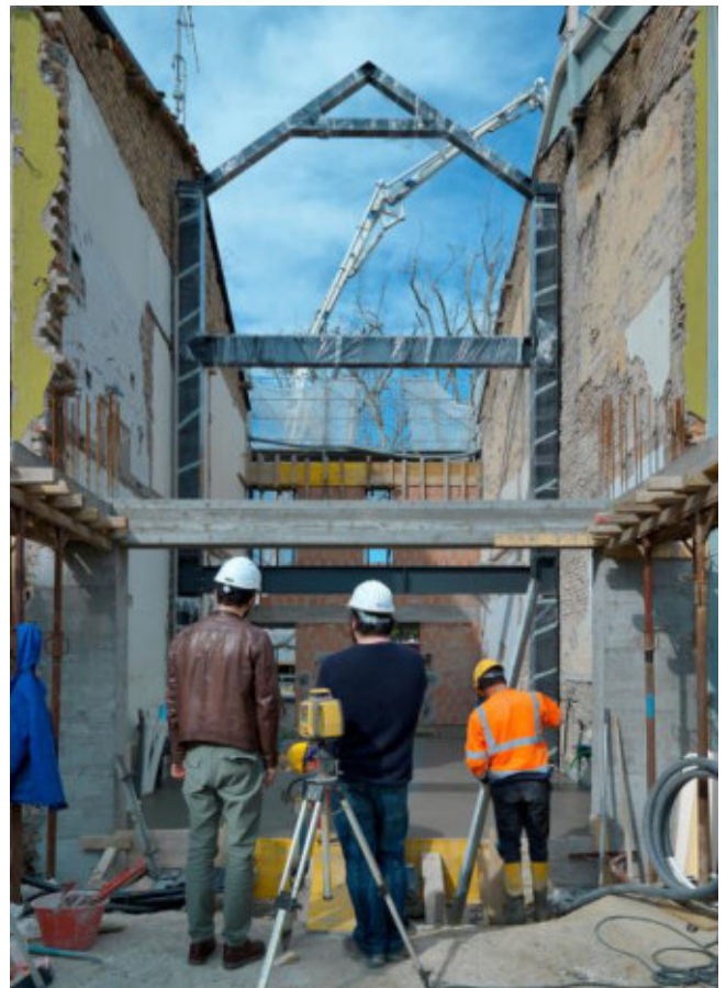
Fig.4 – Foto di cantiere: posa della struttura in acciaio.
