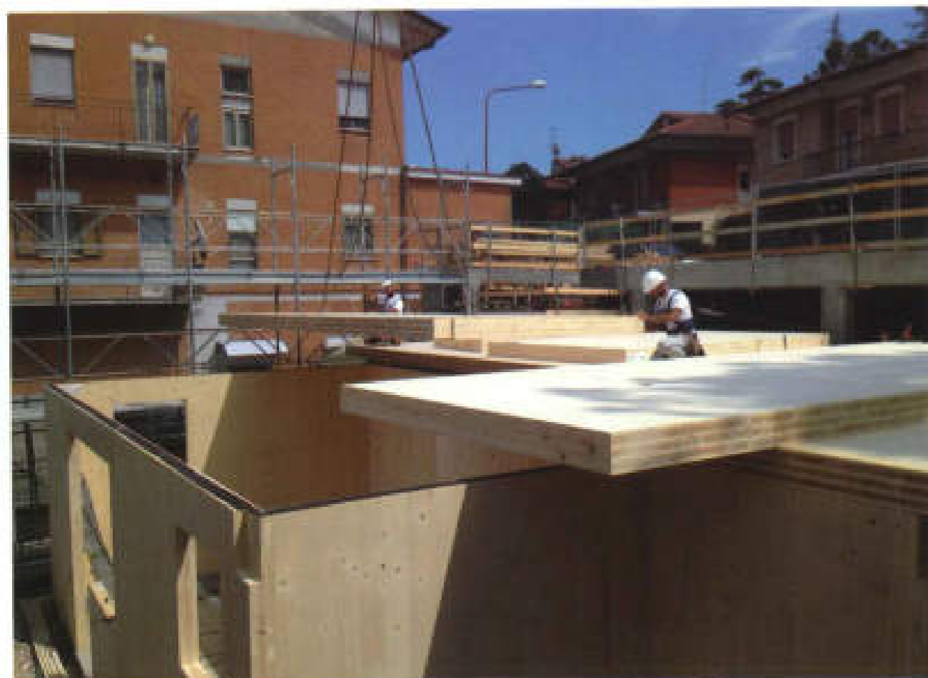
Fiorita Passive House. Montaggio dei pannelli in CLT sagomati in stabilimento. Foto: Studio Piraccini + Potente
