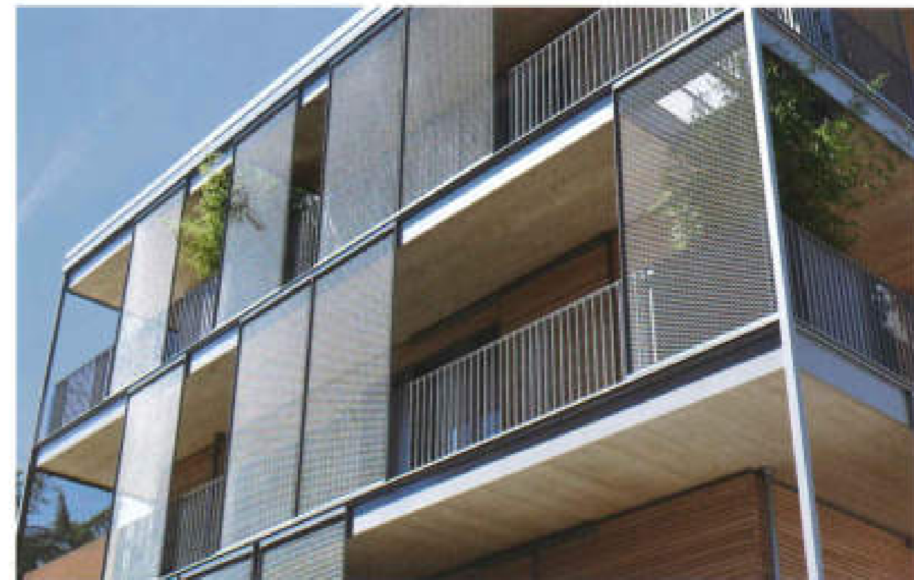
Fiorita Passive House. I balconi che distribuiscono agli 8 appartamenti ed ombreggiano le aperture. Le schermature sono in lamiera sfilata. Foto: Studio Piraccini + Potente
