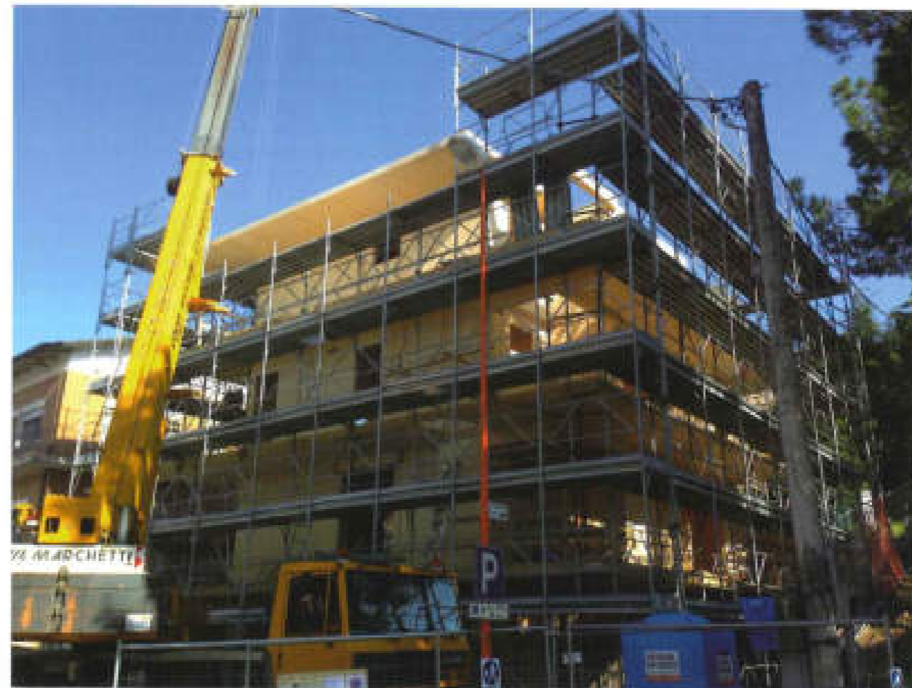
Fiorita Passive House. Fase di cantiere: il montaggio della struttura portante in CLT è quasi completato. Foto: Studio Piraccini + Potente
