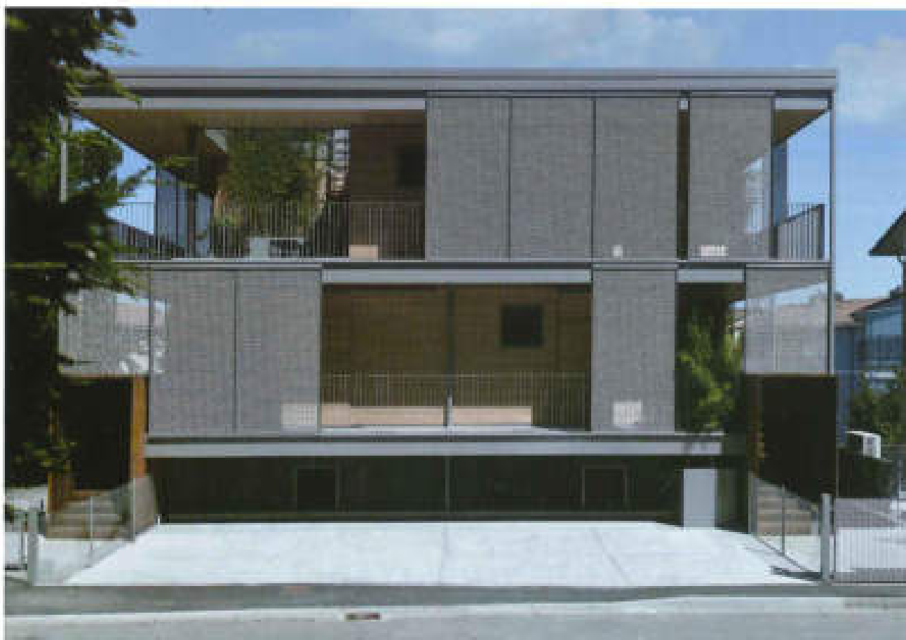
La Fiorita Passive House, edificio plurifamiliare certificato che si trova a Cesena. Foto: Studio Piraccini + Potente
