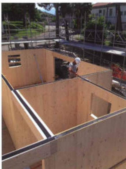
Costruzione di una Passive House in pannelli di CLT.
