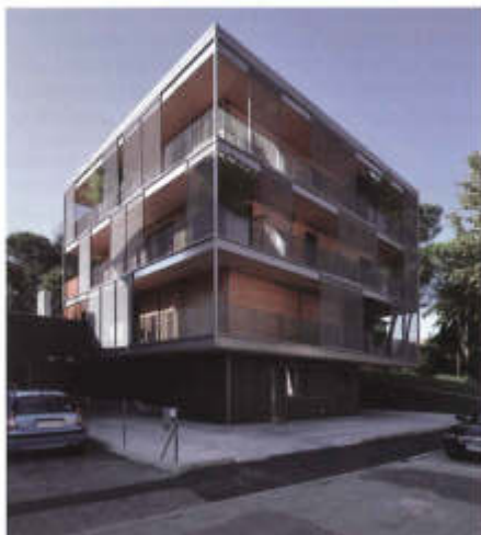
Passive House a destinazione multi-residenziale, costruita in legno con struttura in pannelli di CLT, www.fiontapassivehouse.it .
