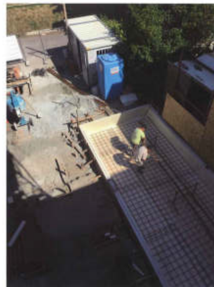
Posa di pannelli di XPS per coibentare le fondazioni di una Passive House in costruzione.
