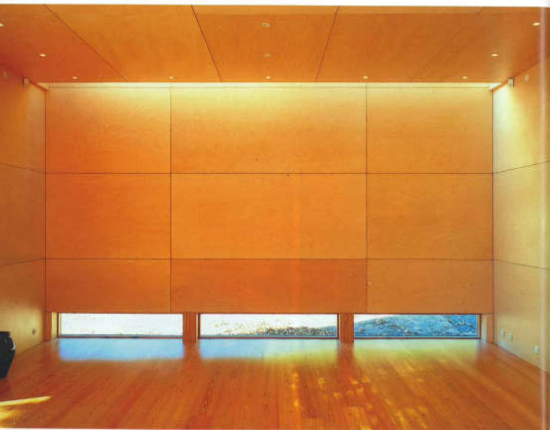
Al sistema di chiusura viene applicato uno strato di rivestimento interno in pannelli di legno al di sotto del quale vengono predisposti gli impianti elettrici.
