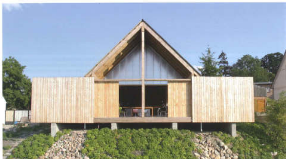
House Michel: nel fronte principale il sistema di pannelli scorrevoli regola il rapporto tra spazi interni ed esterni
