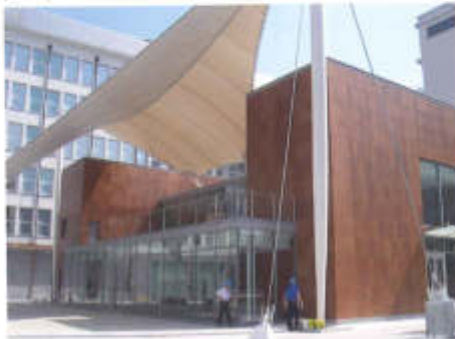
Bodio Center: fronte principale rivestito con pannelli Parklex Facade
