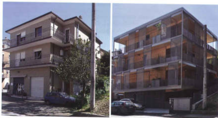
Figure 12.8a e 12.8b – Foto prima (a sinistra) e dopo (a destra) l'intervento
