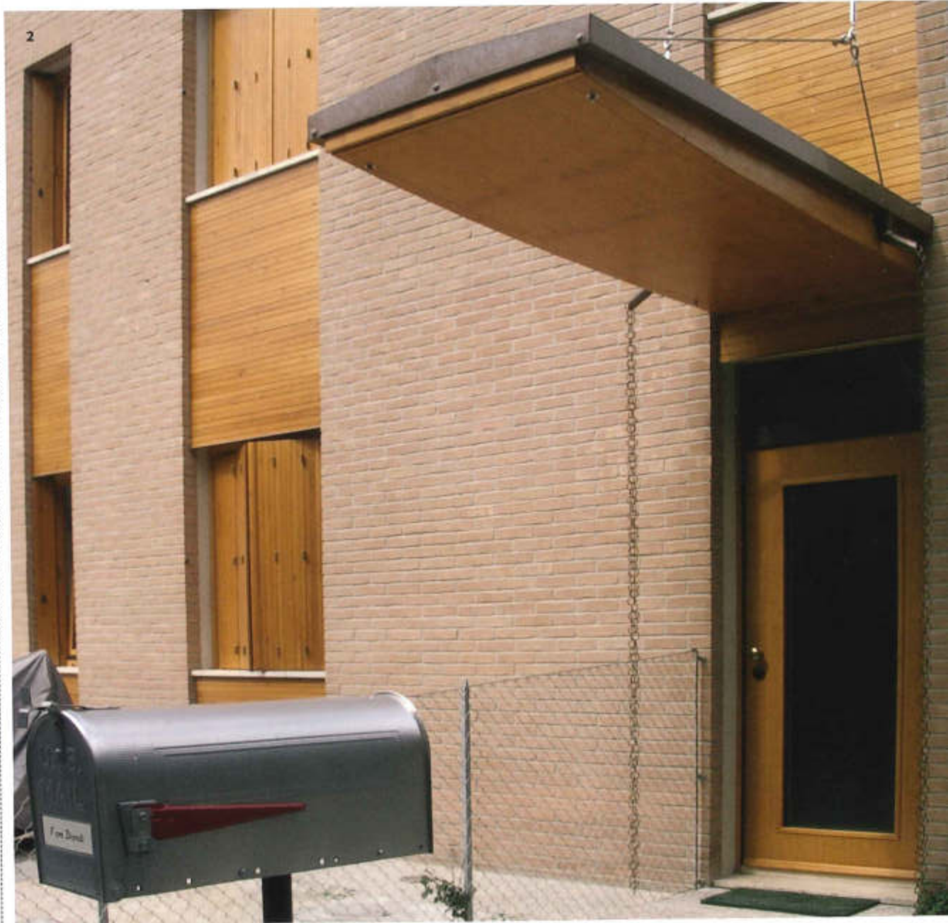
Nella prima pagina Veduta dell'edificio 1 Particolare degli inserti in legno di hemlock così come le porte e le porte-finestre 2 Una delle pensiline poste sopra gli ingressi della facciata principale
